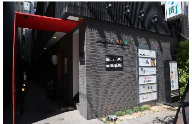
店舗の入る複合施設「船場淡路町・女将小町」
