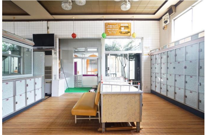
女子脱衣所のロッカーは扉を外し棚として利用
