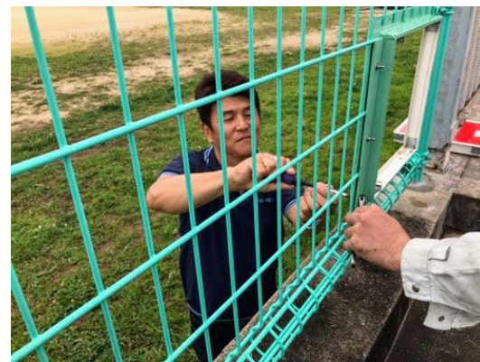
同校ではプールフェンスを取替えを受注
