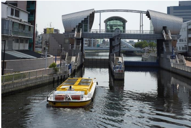
道頓堀川水門
